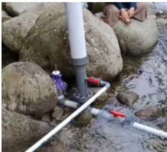
Gambar 3. Kondisi setelah pemasangan pompa hidram
