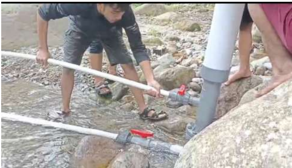
Gambar 2. Proses Pemasangan Pompa Hidram
